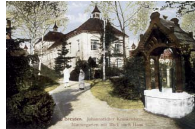
Krankenhaus Johannstadt, Männergarten
